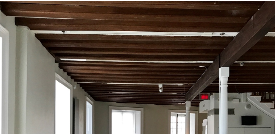
Plafond au rez-de-chaussée
