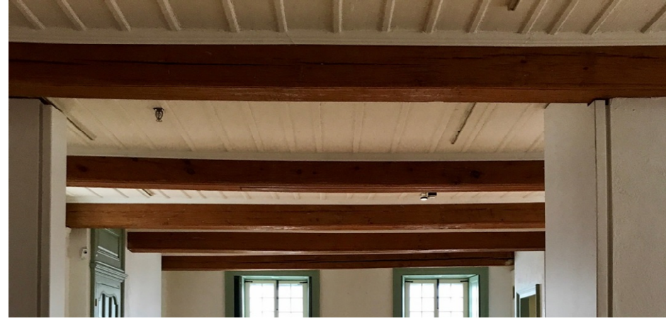
Plafond à l'étage
