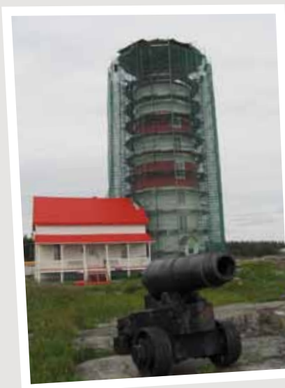
Le phare historique de Pointe-des-Monts, sur la Côte-Nord, en plein réfection.
